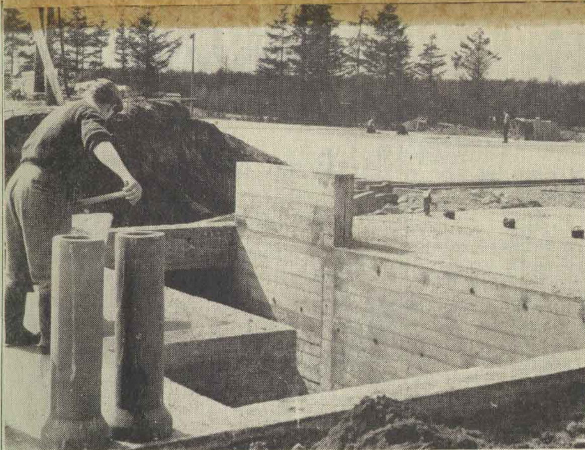
I baggrunden ses teknikere fra Brdr. Gram på den 30×60 m store ishockeybane, og i forgrunden er man i gang med jernbetonarbejdet til maskinstationen
